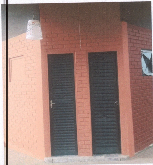
Vista externa dos banheiros
