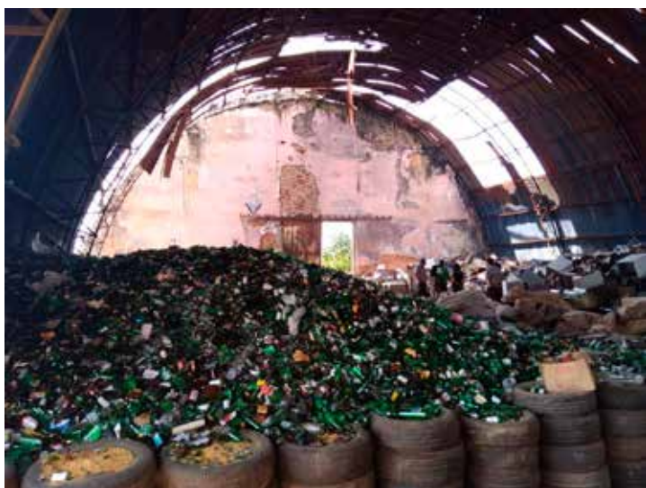
Galpão da extinta CASEGO, cedido à Associação Reciclealto para operacionalização da reciclagem na cidade de Alto Paraíso de Goiás.
