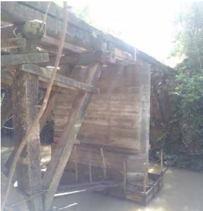
Foi construído o pilar de sustentação
