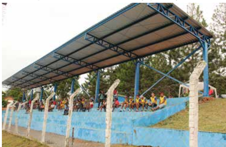
Cobertura da arquibancada
